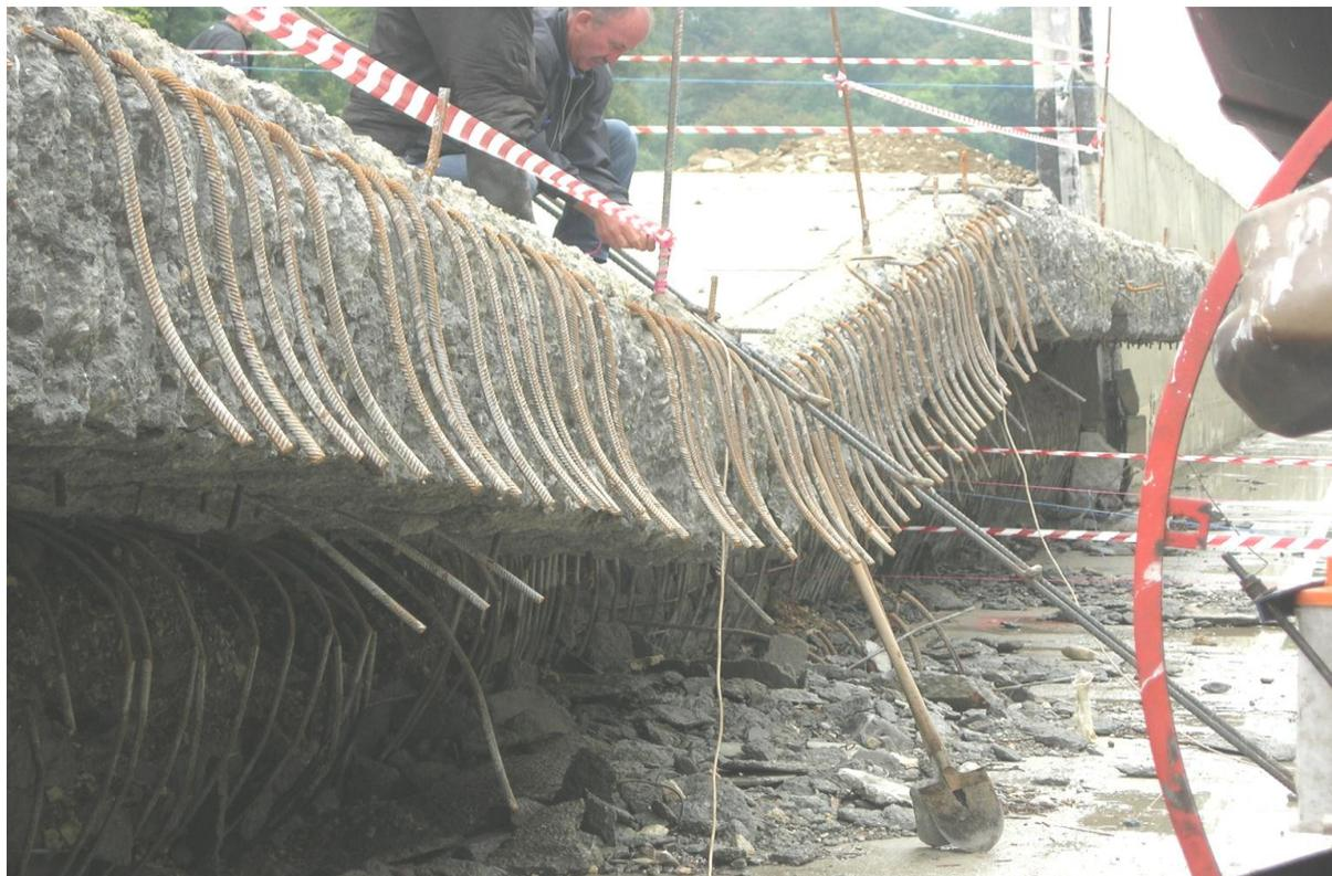
*Рис. 2. Фрагмент разрушенной стенки лотка*
