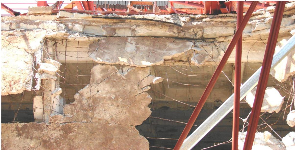
*Рис. 1. Обрушение монолитного ребристого перекрытия*
