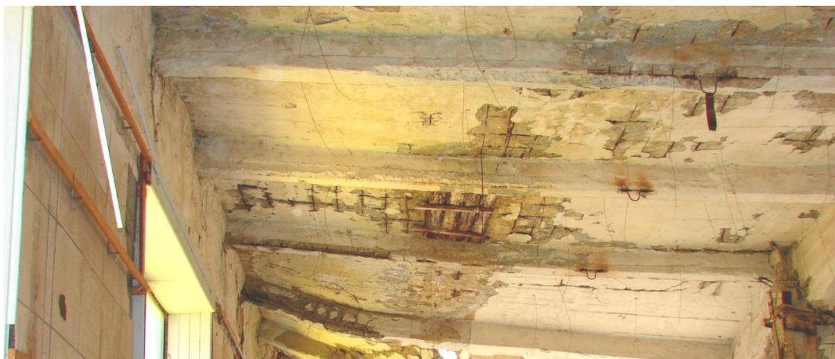
*Рис. 2. Коррозионное повреждение ребристого перекрытия*
